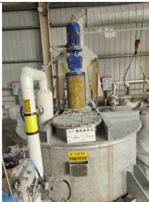
130#线固体助剂投料集气罩收集及布袋除尘器
