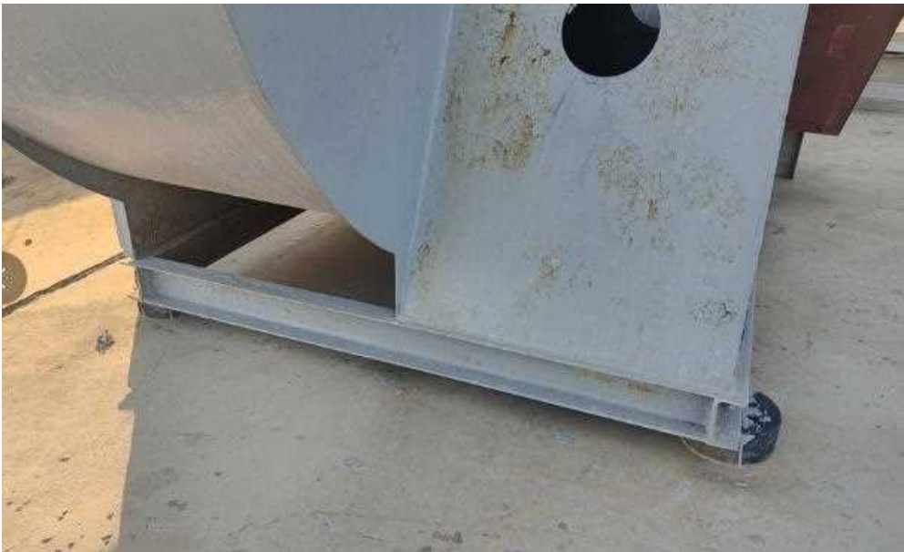
图 4.3-1 风机减振垫照片
