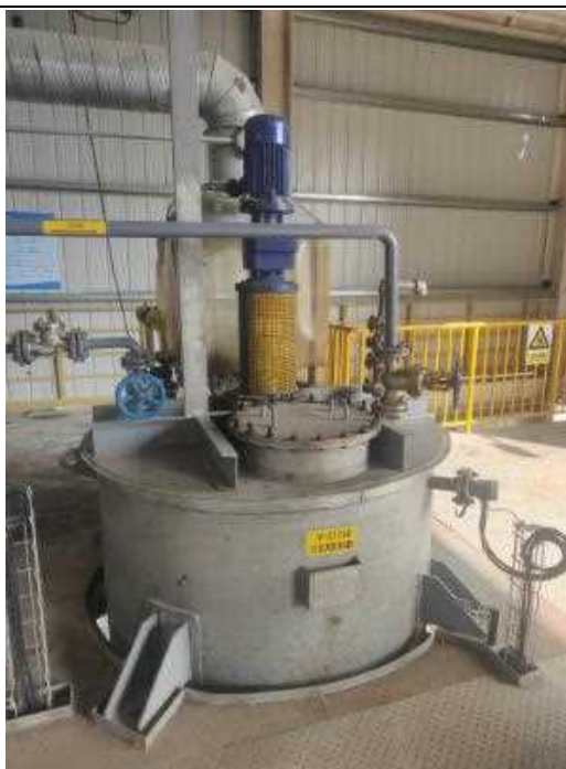
210#线固体助剂投料集气罩收集
