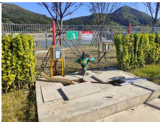
雨排口及雨水闸
